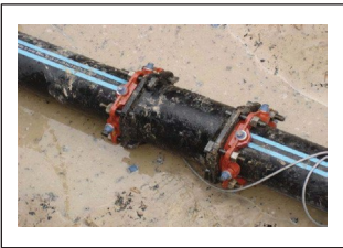
Fig. 23 "Mega-Lug" DIP Spool
